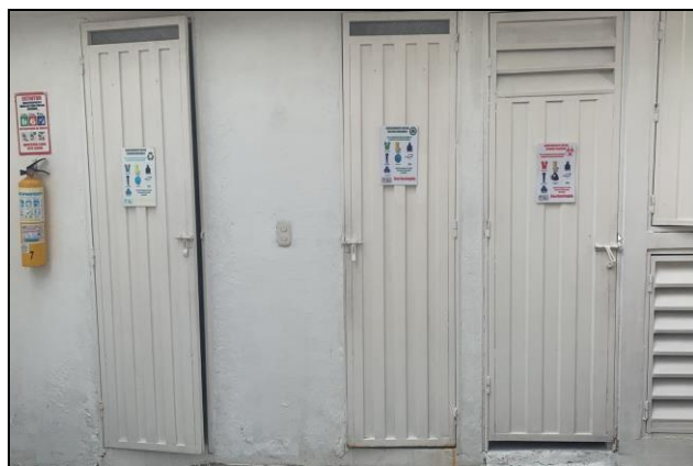
Cuartos de almacenamiento con señalización
