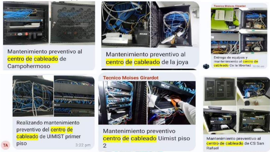
Ilustración 95. Mantenimiento de equipos
