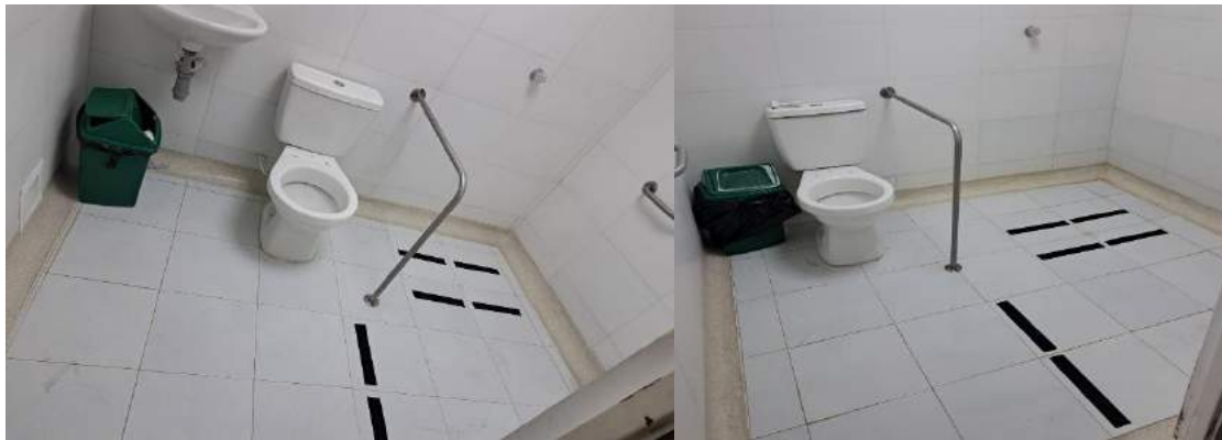
Ilustración 27. Instalación de cintas antideslizantes
