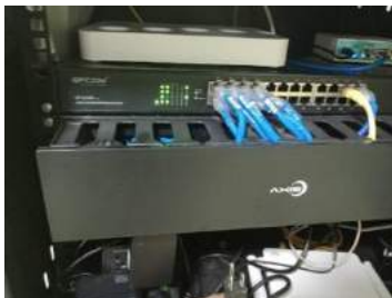
Ilustración 88. Conexión de fibra
