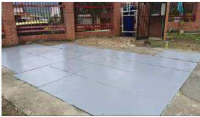
Ilustración 48. Sistema de tratamiento de aguas residuales
