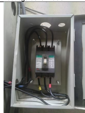
Se realiza tendido de cable 6AWG y totalizador para conexión de circuito nuevo a bodega de farmacia – HLN
