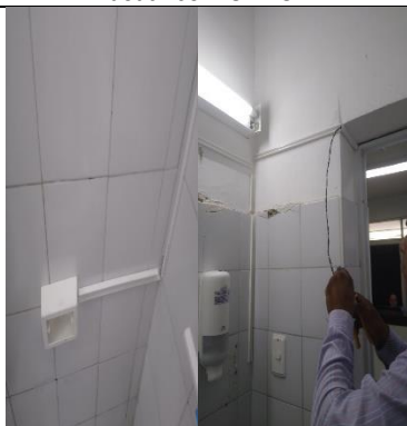
Se realiza adecuación de punto 220v para autoclave laboratorio – UIMIST
