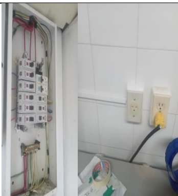
Se realiza adecuación de punto 220v para autoclave laboratorio – UIMIST
