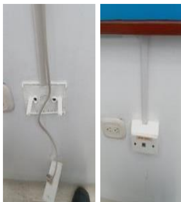
Se cambia toma Corriente en pasillo piso 4 - HLN
