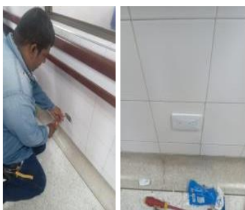
Se cambia toma Corriente en pasillo piso 4 - HLN
