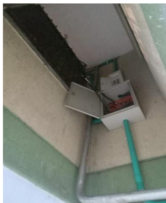
Se cambia caja de datos sala de espera 1 – CS Mutis
