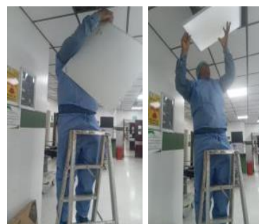
Se cambia 2 panel led de 60x60x45w en cirugía - HLN
